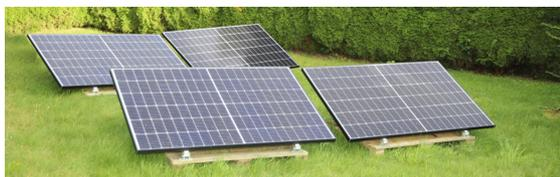
Unsere Solar-Insellösungen sind unabhängig vom öffentlichen Stromnetz. Die Sonnenenergie kann direkt genutzt oder in Batterien gespeichert werden. Für mobile Einsätze liefern wir kleinere PV-Module für Transport im Pkw, für stationäre Einsätze grössere PV-Module.
